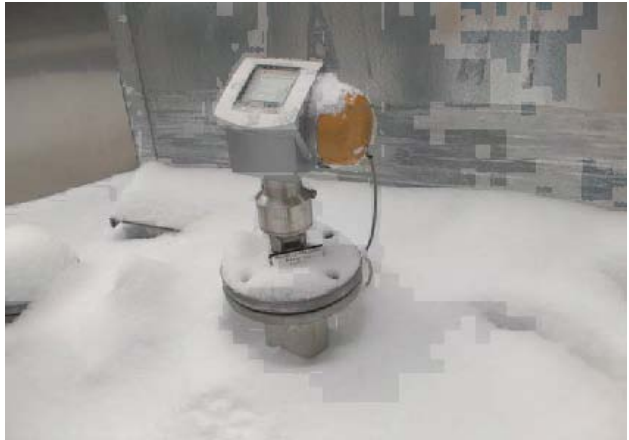
VF7. Bentonite. 11m. Steel
